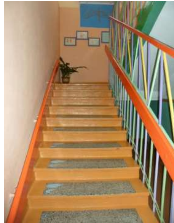
8. Лестница (внутри здания)
